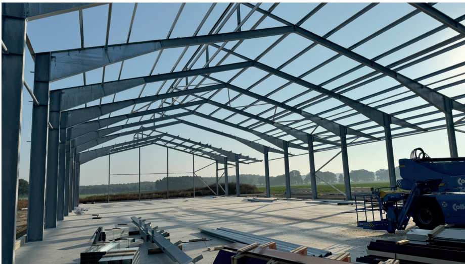
Mit einem Neubau einer Kartoffellagerhalle wird die Langzeitlagerung abgesichert.
